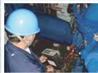
ポンプにセンサーを取り付け、マシンチェッカーで状態を測定します。
