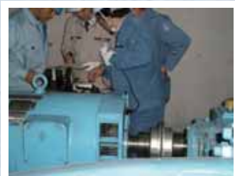
モータ軸受の振動レベル測定 (軸方向)
