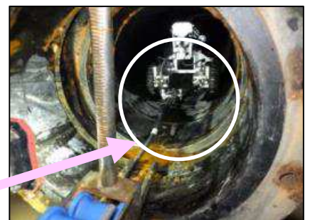
管内面調査+継手間隔計測状況
