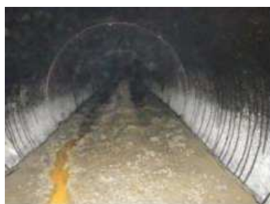
堆砂撤去前(写真②)
