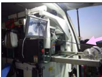
専用車両によるケーブル送り出し状況 (写真①)
