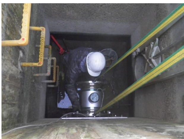
流量計室内における機器設置状況
