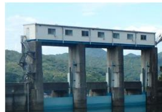
三川ダム_洪水吐ゲート・門柱
