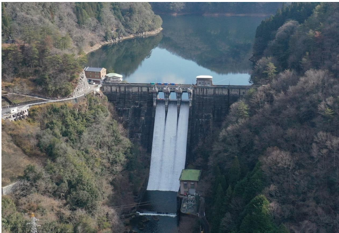
小阪部川ダム全景
