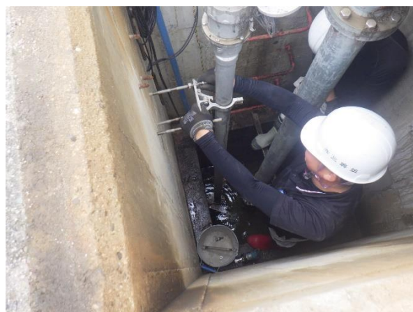
制水弁室内における弁設置状況
