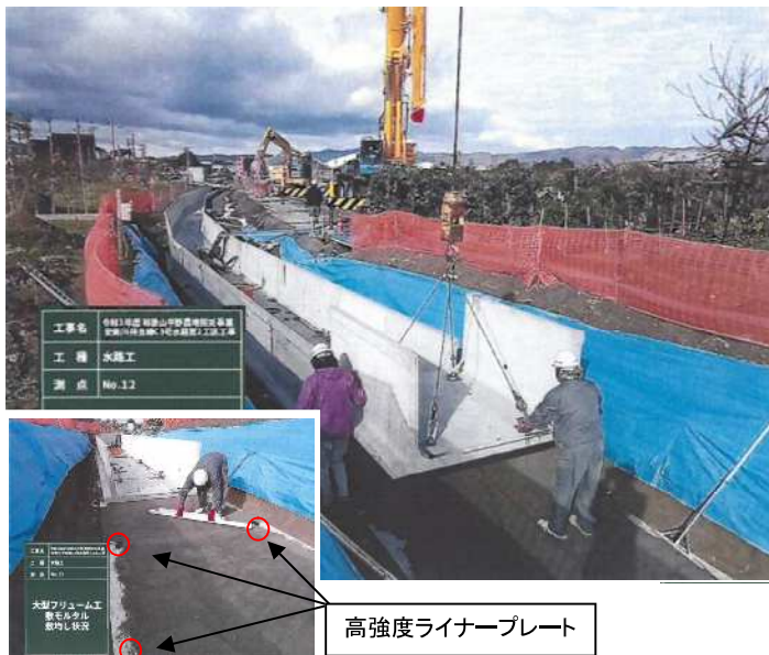
大型フリーダム据付状況
