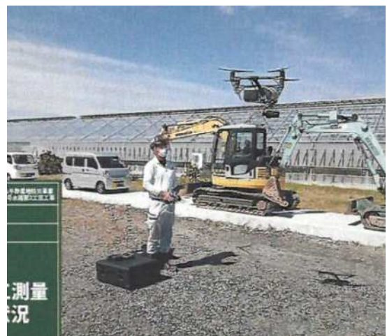
UAV起工測量状況
