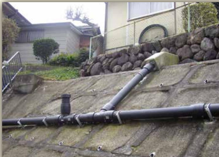
■取り付け管及び点検孔
