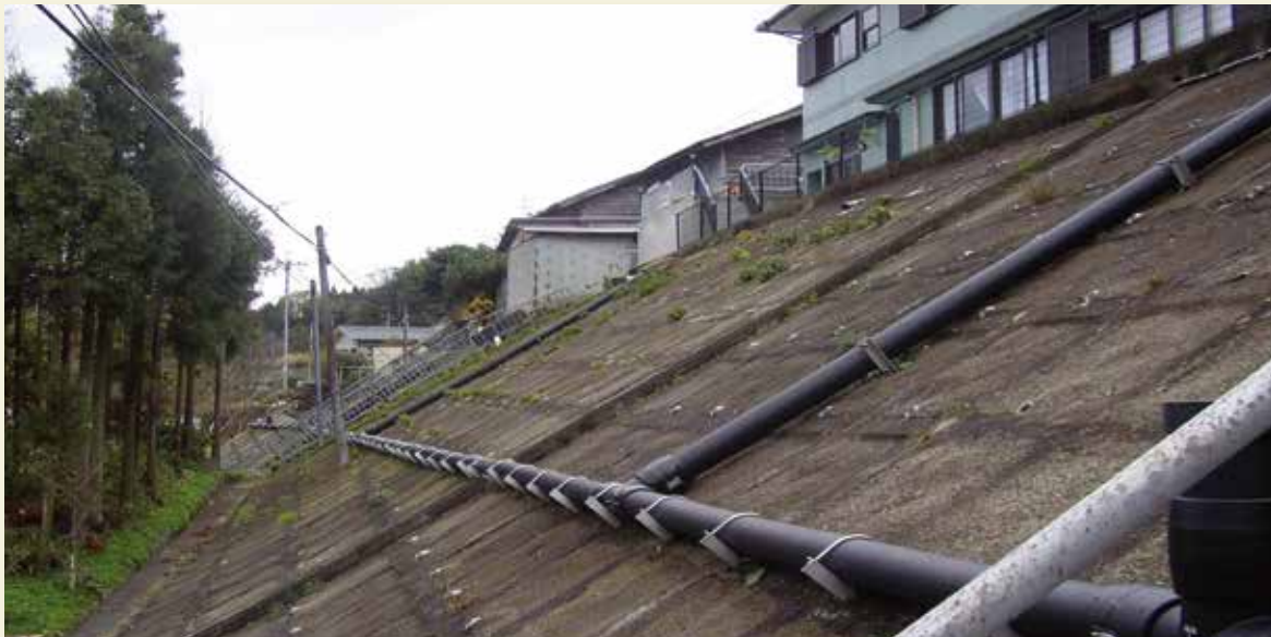
■露出配管全景
