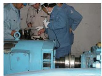
モータ軸受の振動レベル測定
