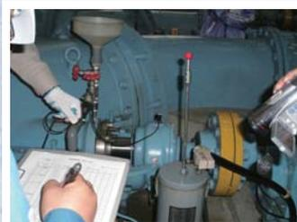
モータ軸受の振動レベル測定
