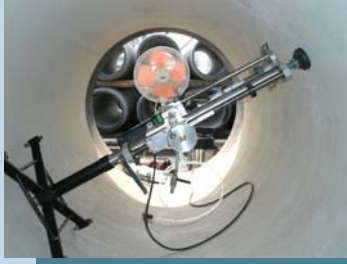
サンプラー据付
