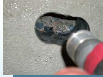
大径孔 孔底さらい
