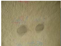
急結モルタル充填
